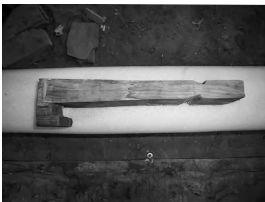
4、「ろ九」～「は九」繋ぎ梁の切断されていた長柄
