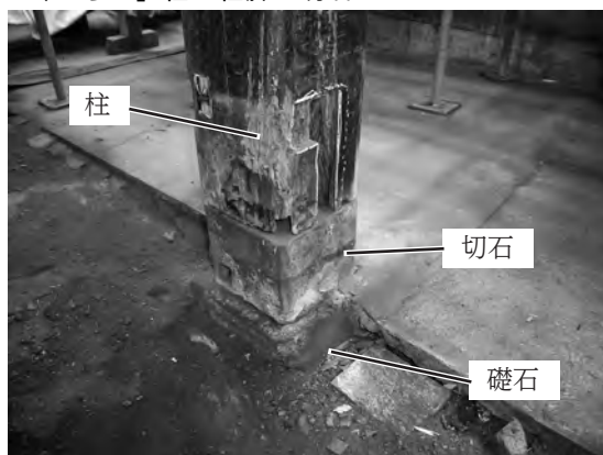
3、「か五」柱 柱脚の切石
