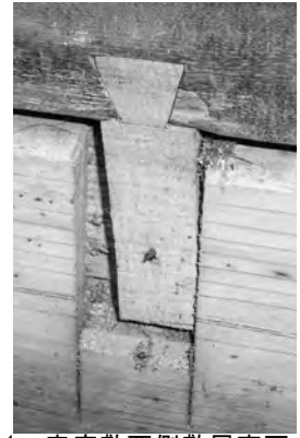
1、表座敷西側敷居東面
