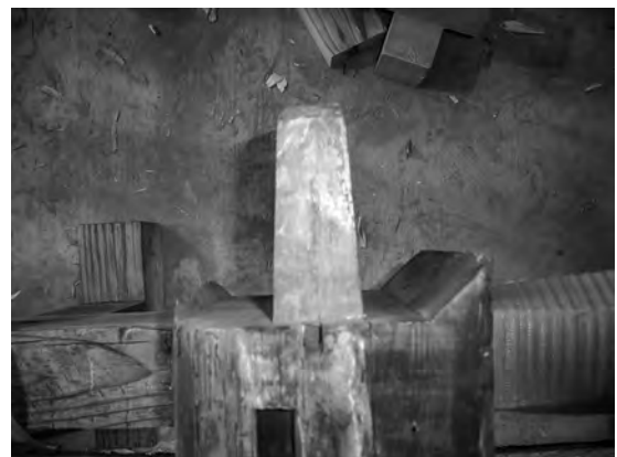
写真 2-2、「は二」柱 柱頭枅
