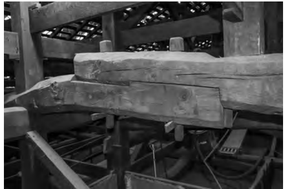
3、敷梁継手 敷桁・差桁・差梁も同じ
