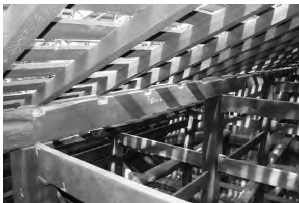
2、垂木彫りの痕跡 写真 2-7、母屋当初転用材の痕跡
