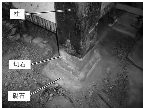
1、「ち五」柱 柱脚の切石
