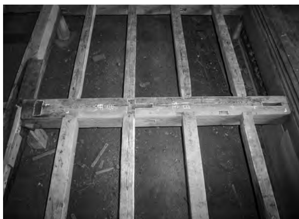
1、敷居・鴨居・枅穴の痕跡
