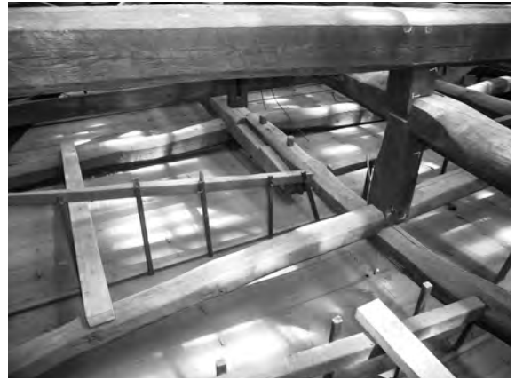
1、上：敷桁・敷梁、下：差桁・差梁
