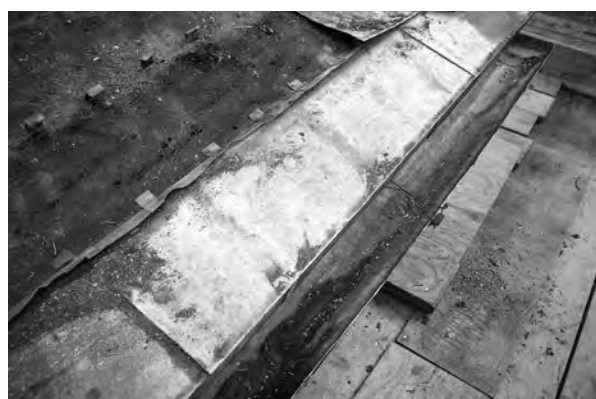
1、西下屋軒先状況 土居葺・吊子・銅板
