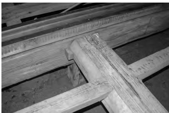
2、足固めと大引の納まり 写真 2-9、当初床組
