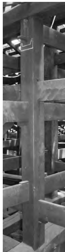
4、壁留めの痕跡
