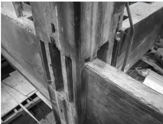
2、「は九」柱南東面仕口
