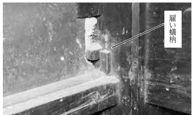
2、「は六」柱東面鴨居納まり
