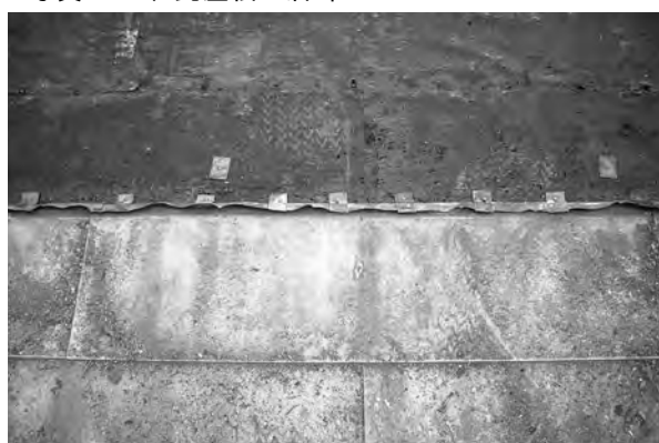
2、西下屋平葺状況 土居葺・吊子・銅板
