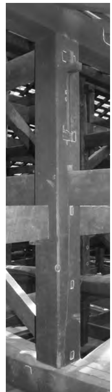
1、敷居・鴨居 間渡し穴の 痕跡
