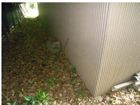
【写真 92】東側状況
