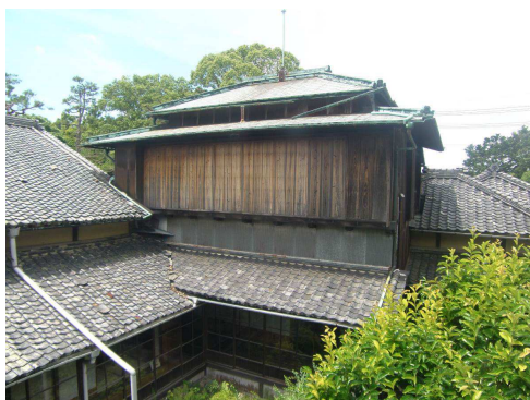
【写真 140】 東側状況
