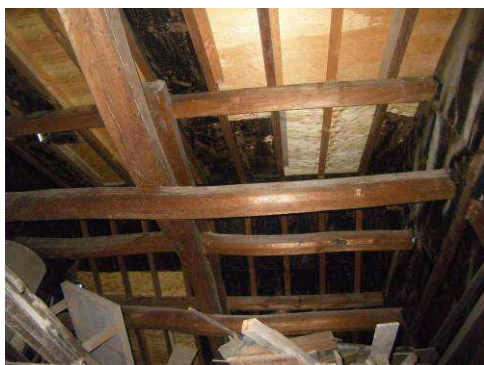
【写真 168】小屋組状況
