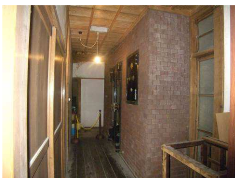
【写真 176】外部状況
