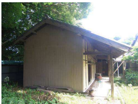
【写真 100】北側状況
