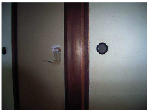
【写真 144】 引手金物の欠失
