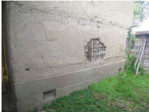
【写真 64】外壁状況
