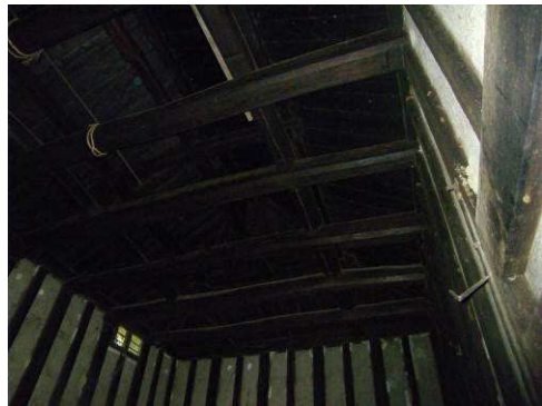
【写真 67】換気窓状況
