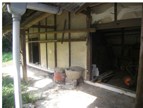
【写真 93】西側状況
