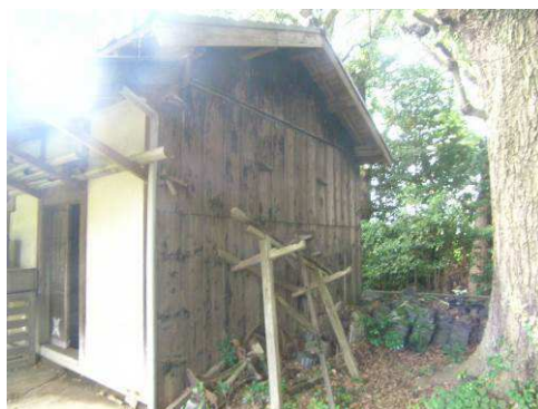
【写真 173】東側状況
