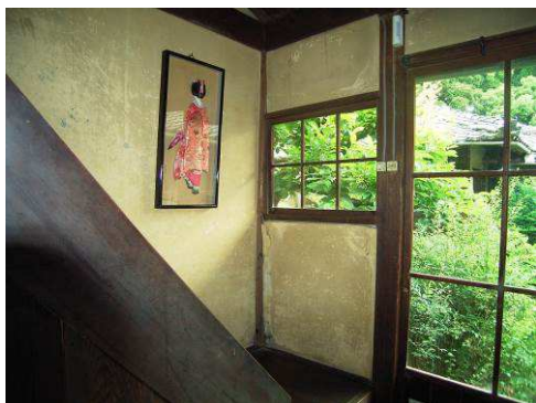
【写真 142】 「階段」壁状況
