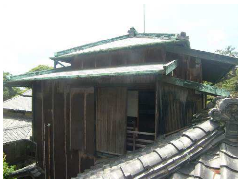
【写真 141】 北側状況
