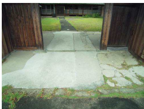
【写真 39】通路の土間状況
