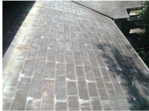
【写真 33】「広縁」屋根状況
