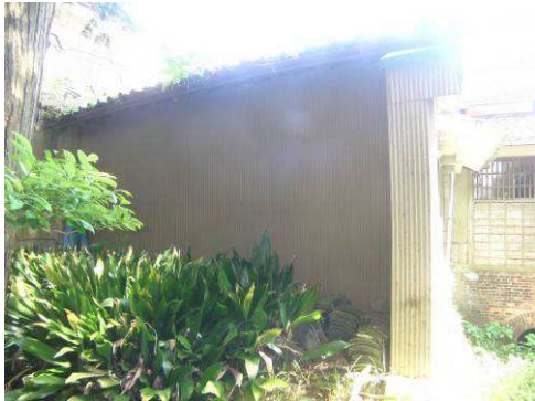
【写真 78】北側外壁状況
