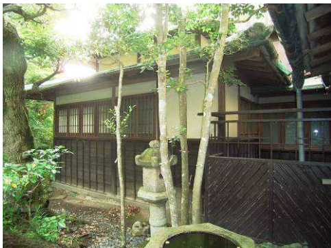
【写真8】風呂・便所棟南面
