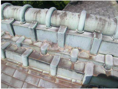
【写真 32】「式台」屋根状況
