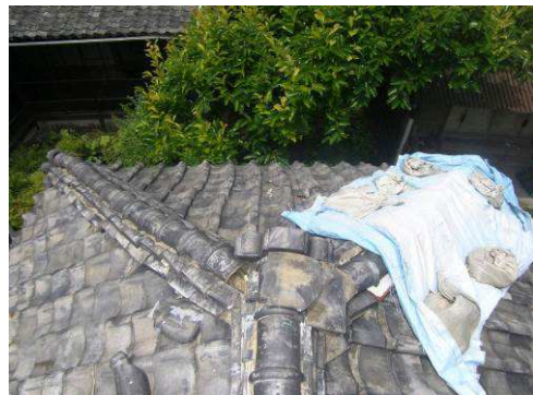
【写真 185】北西隅状況
