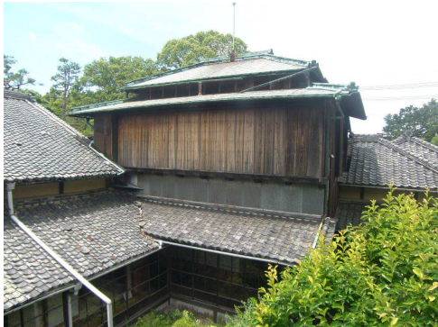
【写真10】二階屋東面
