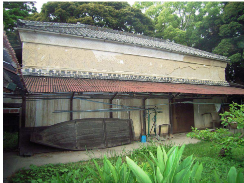
【写真 161】南側状況
