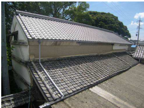
【写真 62】大屋根状況
