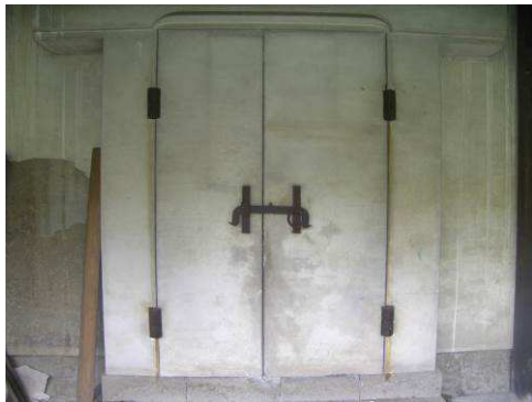
【写真 88】塗戸状況
