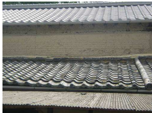
【写真 63】下屋庇状況
