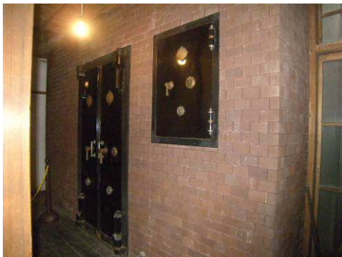
【写真14】金庫蔵西面
