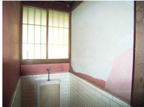
【写真 187】 上塗り剥落
