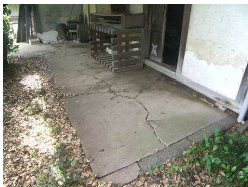
【写真164】軒内土間状況
