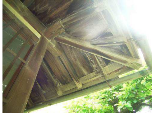
【写真 181】北西隅軒裏状況
