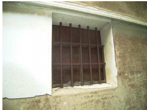
【写真 89】鉄扉状況
