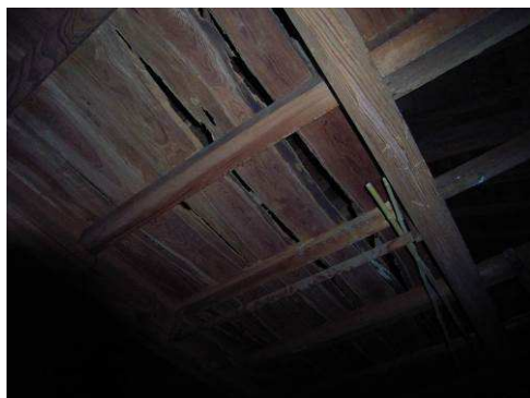
【写真 69】二階床状況
