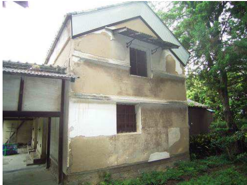
【写真 86】北側状況
