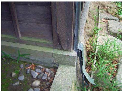
【写真108】「便所」北西隅柱脚
