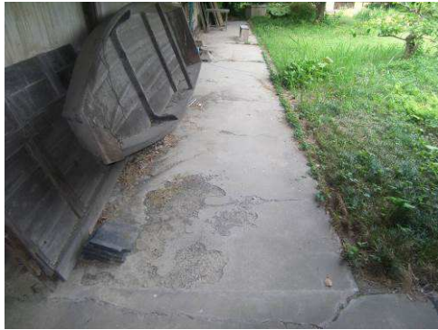
【写真 154】軒内土間状況
