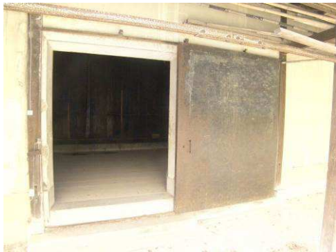
【写真 66】鉄扉状況
