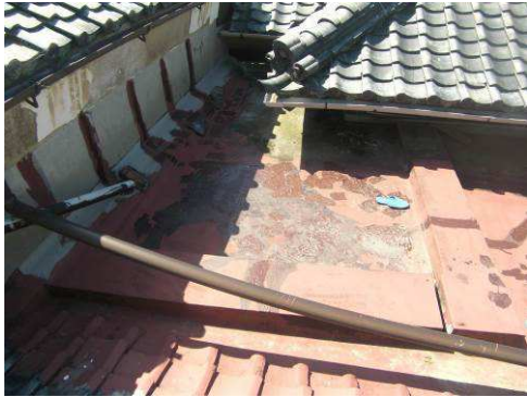
【写真 178】陸屋根状況
