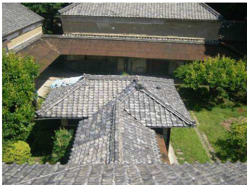
【写真 184】屋根状況
