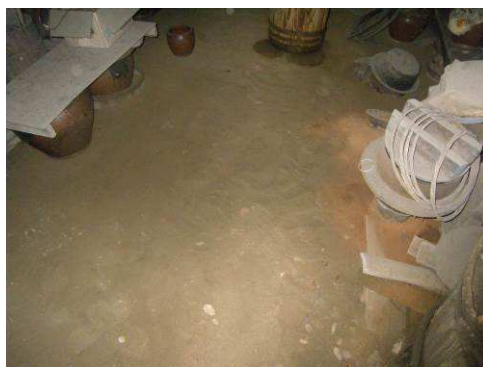
【写真165】「東室」土間状況
