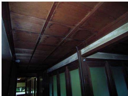
【写真109】「南廊下(東)」天井
