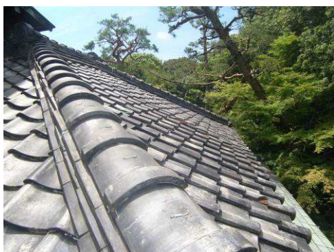
【写真 112】 平葺の葺き乱れ
