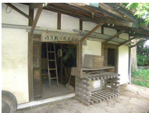
【写真 172】南側状況
