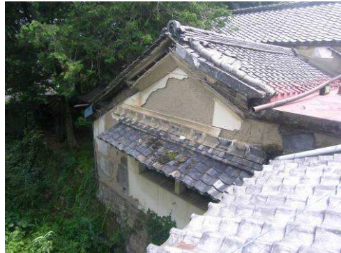
【写真 79】西側外壁状況
