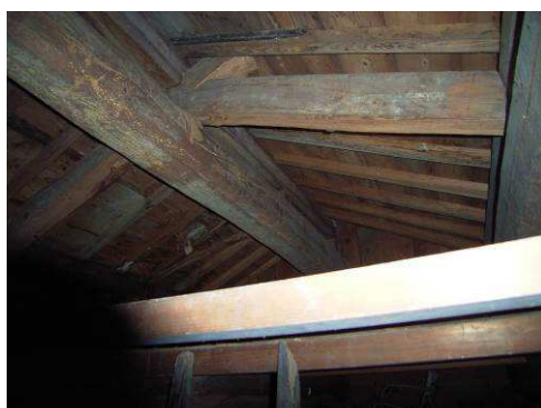
【写真 71】小屋組状況
