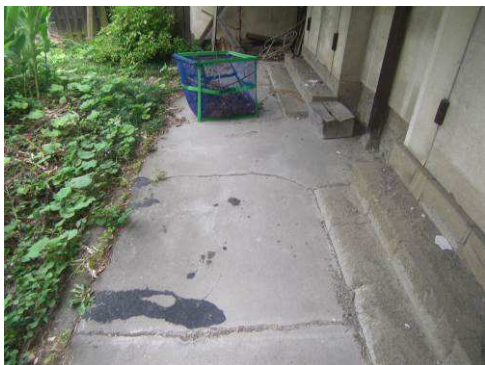
【写真 80】土間状況
