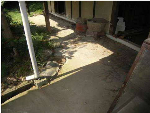
【写真 94】土台状況
