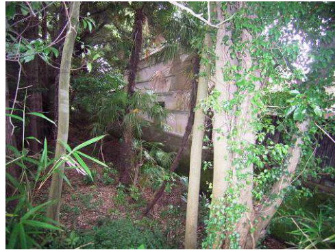
【写真 155】堀石垣状況
