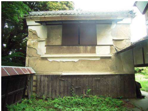
【写真 160】西側状況
