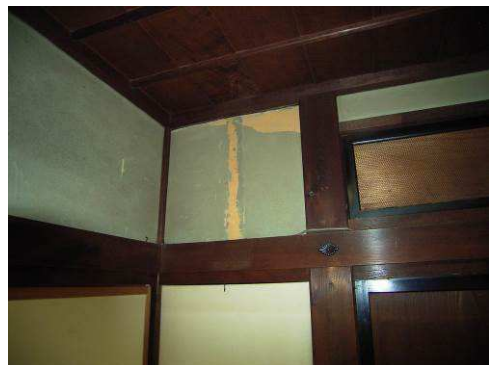
【写真 35】「十畳」上塗り剥落
