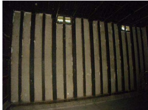
【写真 65】内壁状況
