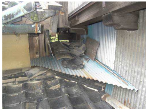
【写真 139】取合い状況
