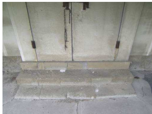
【写真 81】石段状況
