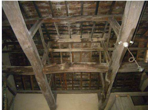
【写真 95】「北室」小屋組状況
