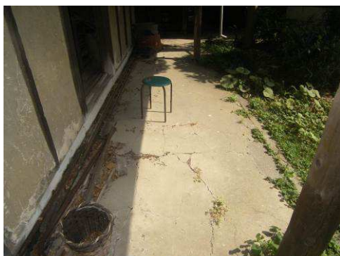
【写真 90】軒内状況
