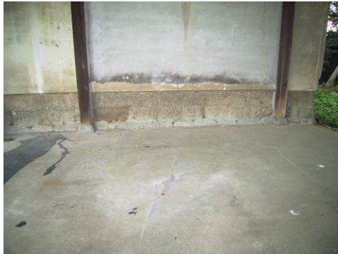
【写真 82】礎石状況
