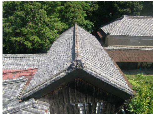
【写真 85】棟通り状況
