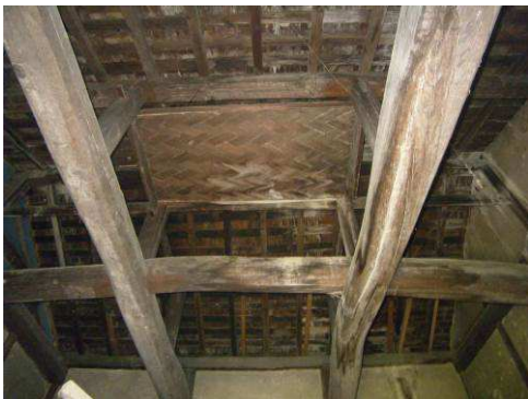
【写真 96】「南室」小屋組状況
