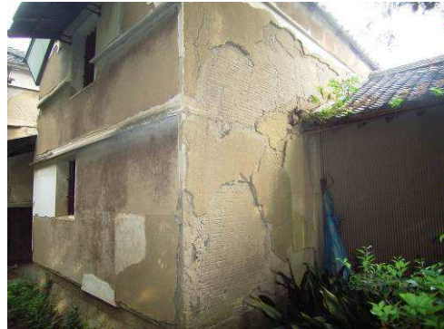
【写真 87】西側状況
