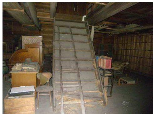
【写真 157】階段状況
