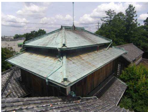
【写真 138】銅板状況
