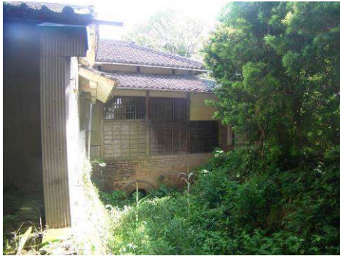
【写真 120】暗渠状況
