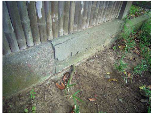
【写真 121】「中廊下 (南)」西橋礎石
