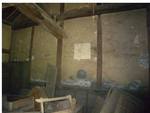
【写真 103】内壁状況
