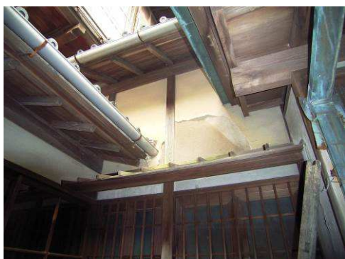
【写真 114】 上塗り剥落
