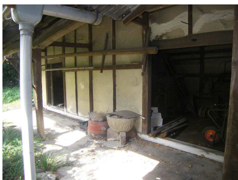
【写真 102】西側状況
