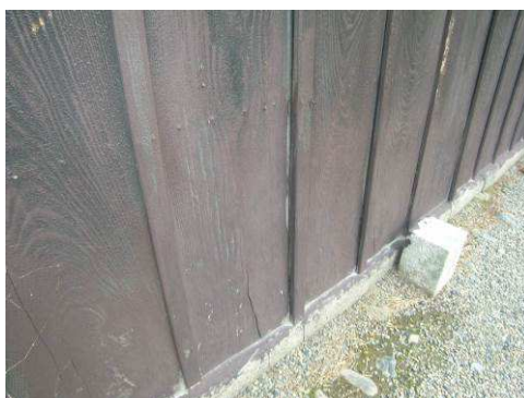
【写真149】「仕切塀」腰板
