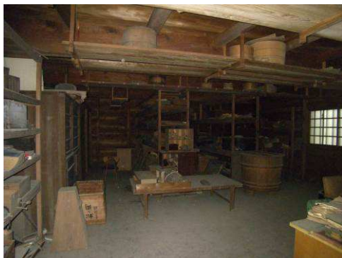
【写真 156】内部状況
