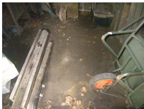
【写真 91】土間状況
