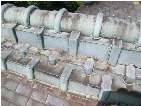
【写真 32】「式台」屋根状況
