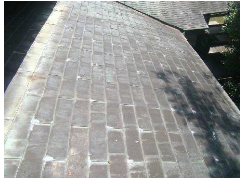
【写真 33】「広縁」屋根状況
