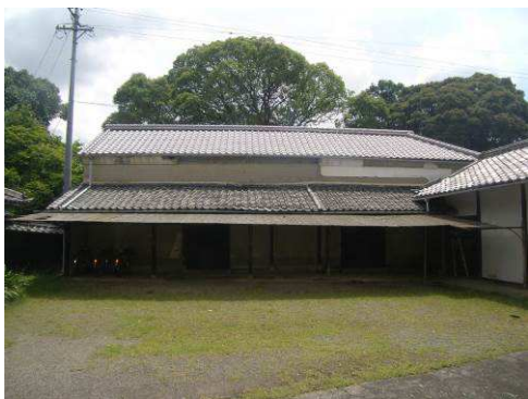
【写真4】米蔵西面
