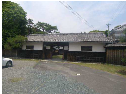
【写真3】長屋門南面
