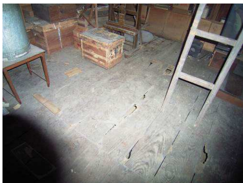
【写真 68】一階床状況
