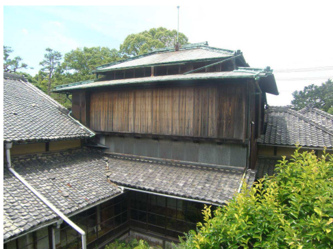
【写真10】二階屋東面
