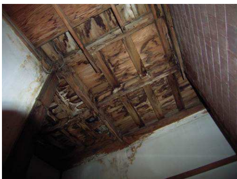
【写真 72】天井状況
