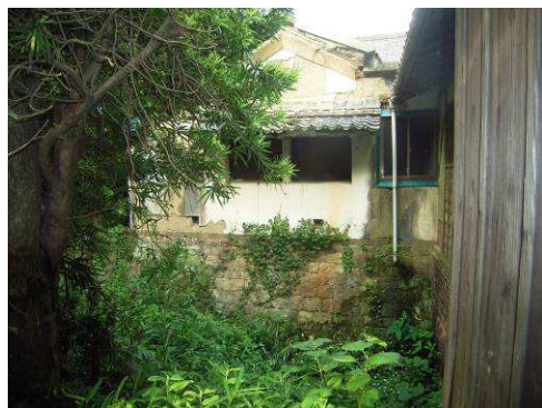
【写真5】奥蔵西面
