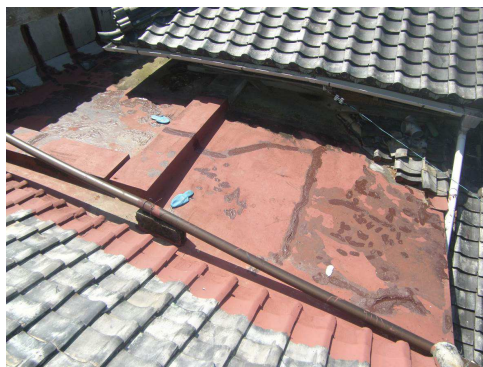
【写真 75】陸屋根状況
