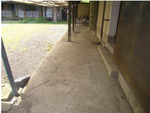
【写真 56】叩き状況
