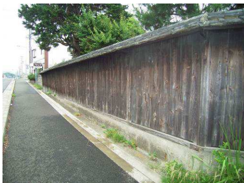
【写真16】西板塀西面
