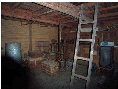
【写真 76】内壁状況
