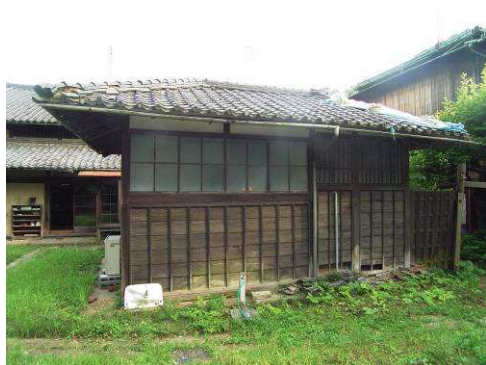
【写真15】新風呂・便所棟北面
