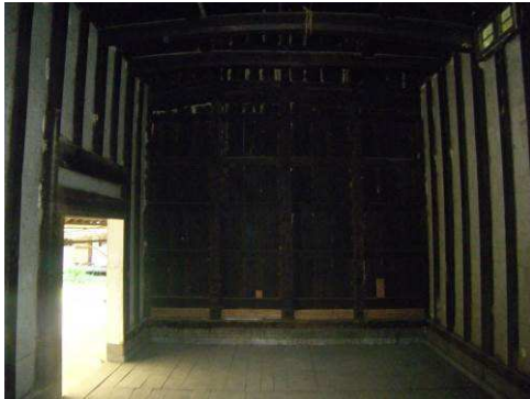
【写真 60】間仕切り壁状況
