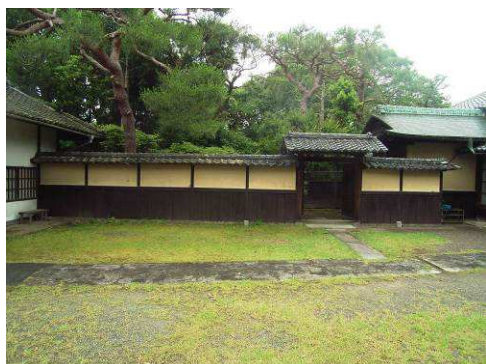
【写真11】中門・仕切塀東面
