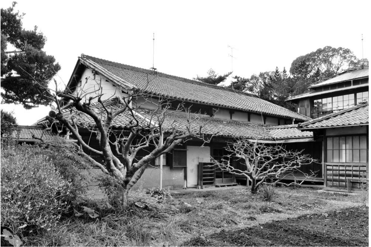
5. 主屋背面全景(北東より)
