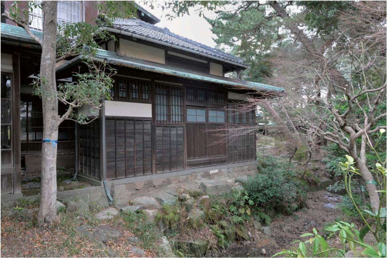
8. 風呂・便所棟 全景（北西より）
