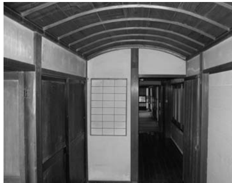
図 3-19 渡り廊下の蒲鉾天井（北より）
