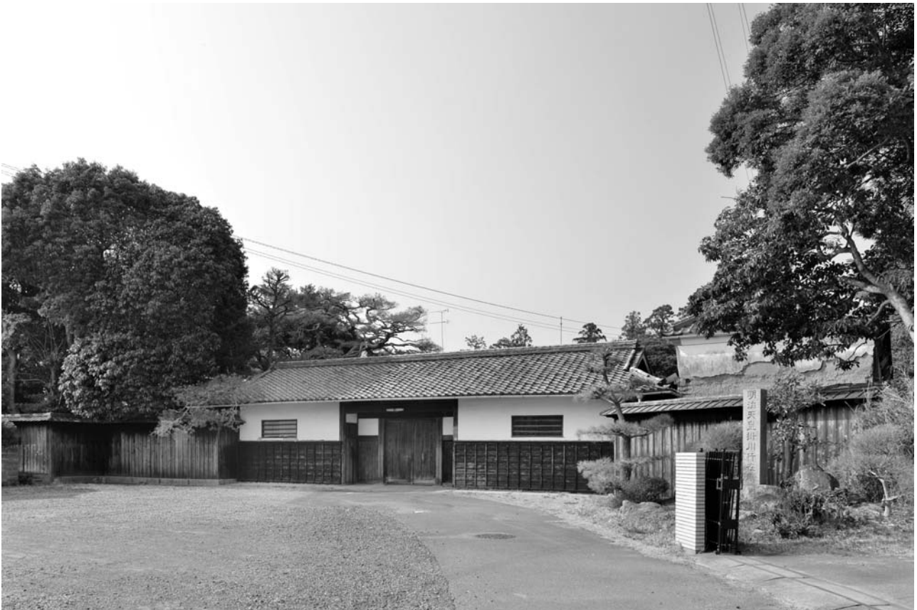
34. 沿道から見る長屋門（現況）
