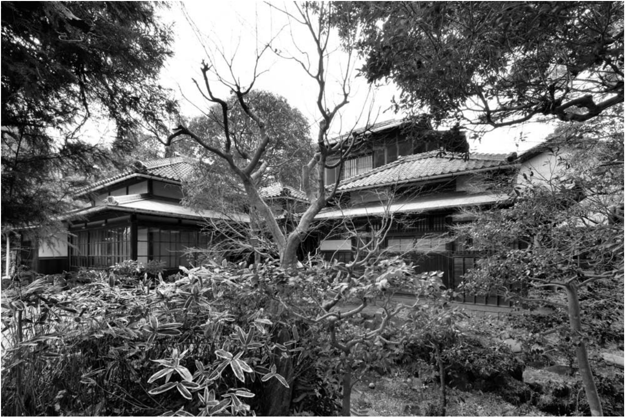
11. 風呂・便所棟、奥座敷棟、二階屋（西より）
