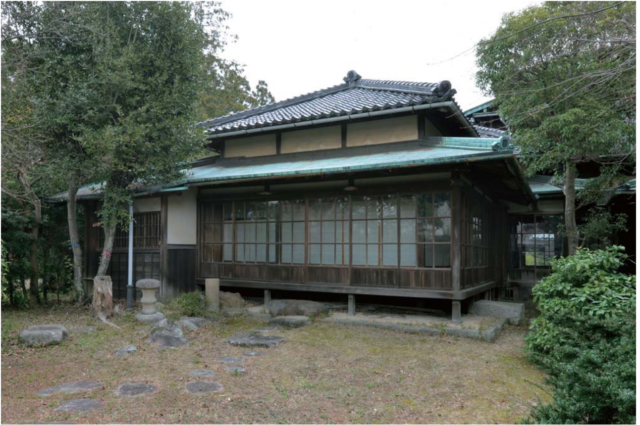
6. 奥座敷棟 全景（西より）
