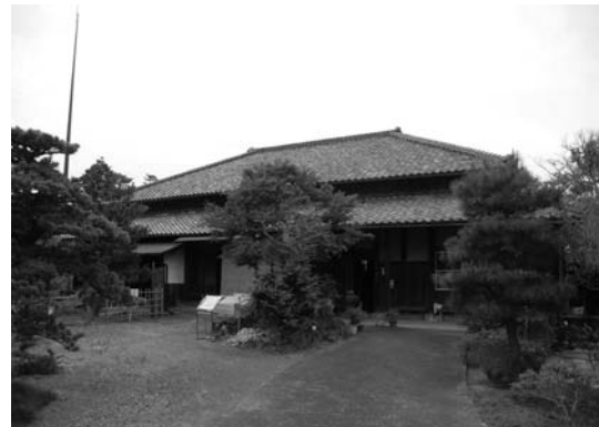
図 4-6 黒田家住宅主屋 (南より)
