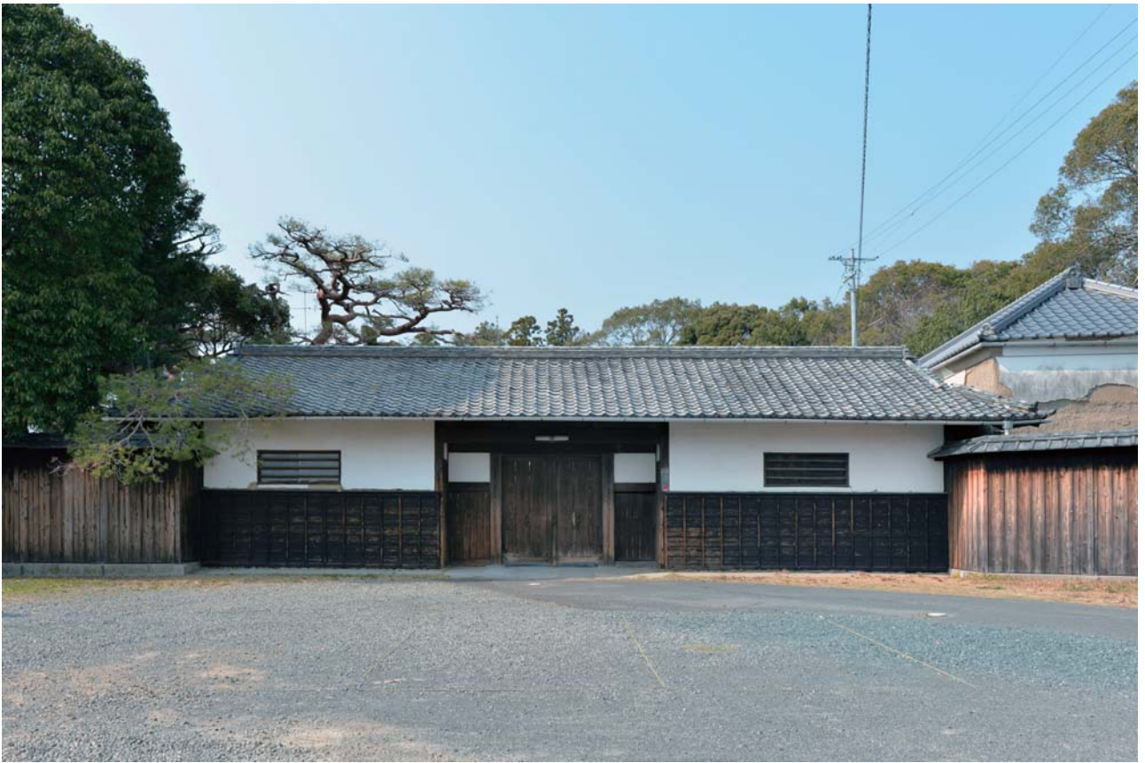
10. 長屋門 全景（南より）
