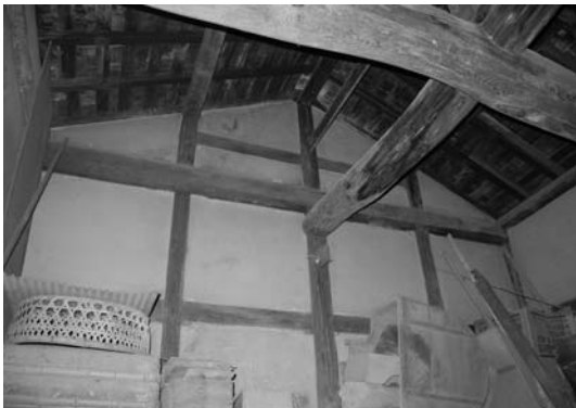
図 3-30 納屋南側室内小屋組み (南より)
