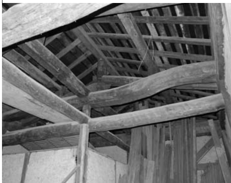
図 3-25 長屋門小屋組み (東より)
