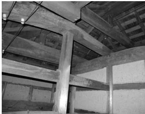
図 3-23 風呂・便所棟の小屋組み
