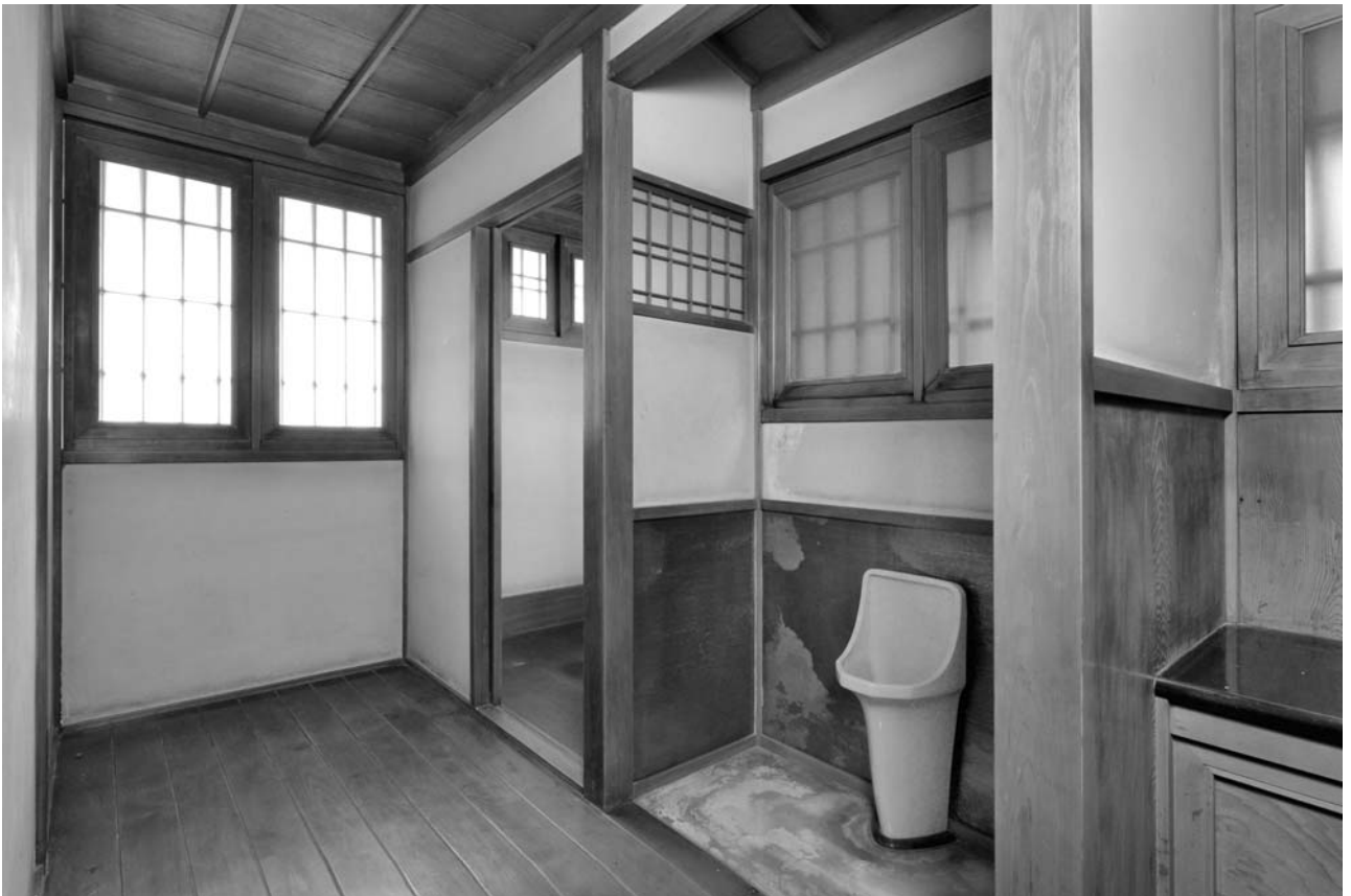
16. 風呂・便所棟便所（北東より）
