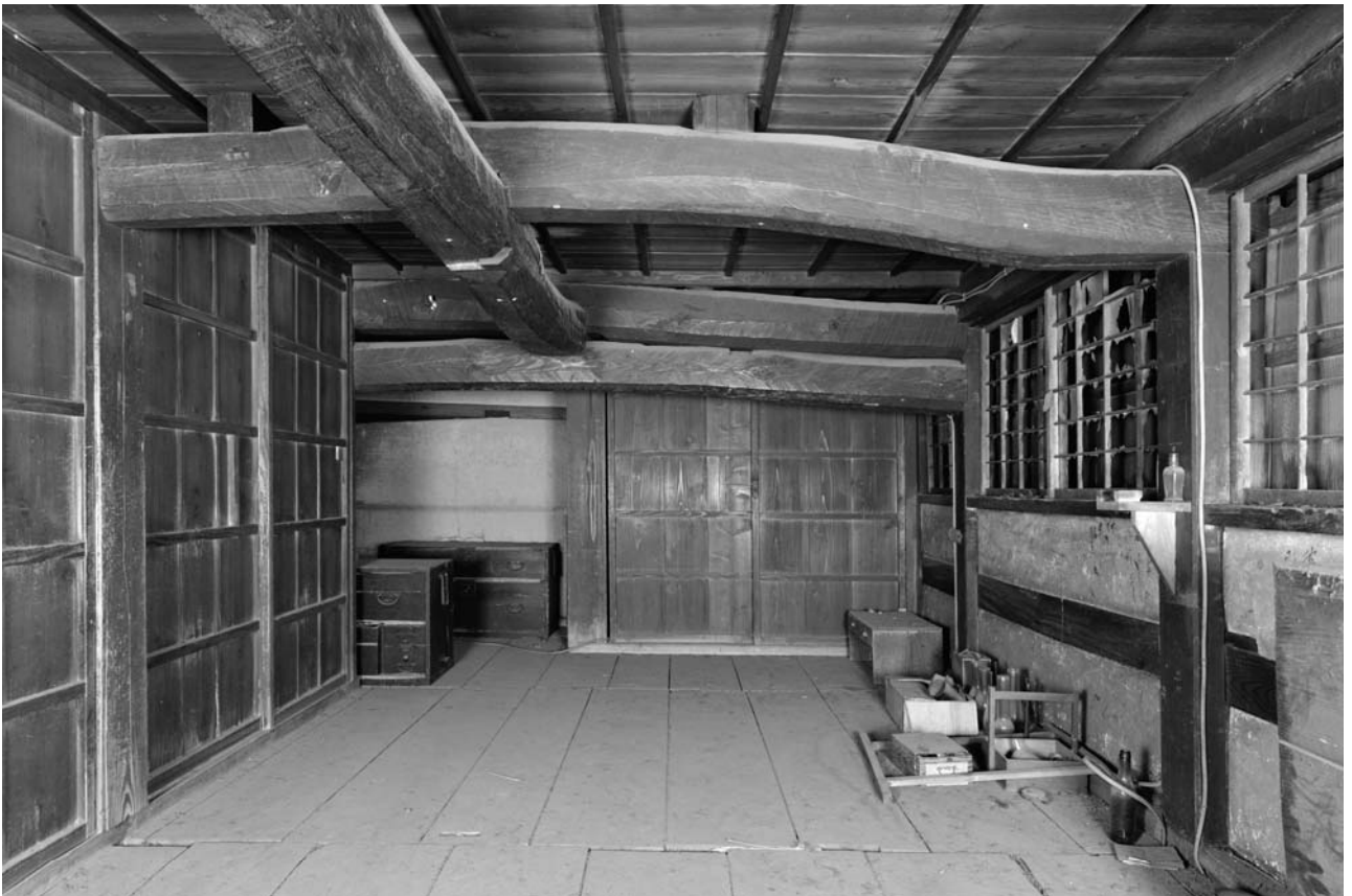
10. 主屋二階（西より）
