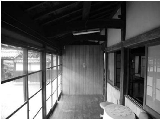
図 3-10 正面土間側の縁（東より）
