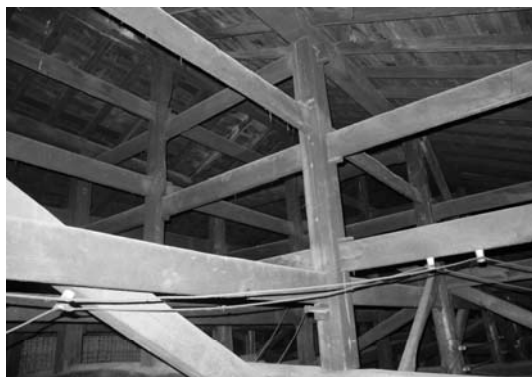
図 4-9 旧山崎家住宅西側小屋組み (床上部)
