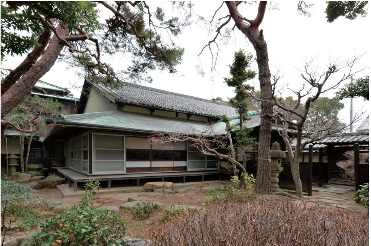
2. 主屋 正面全景（南西より）
