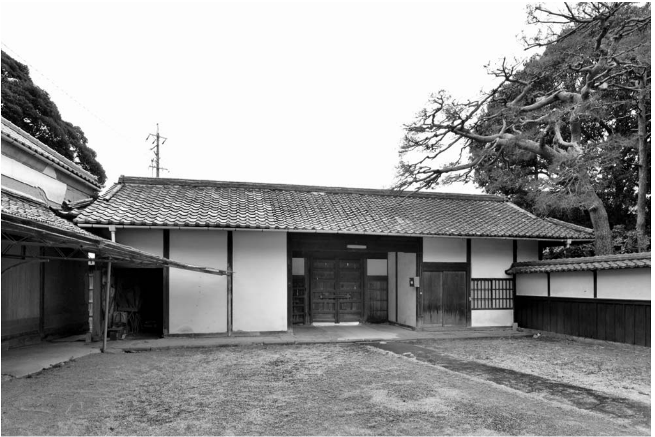
17. 長屋門背面全景（北より）
