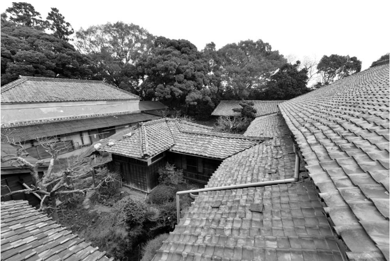
2. 屋敷地背面側（二階屋より望む）
