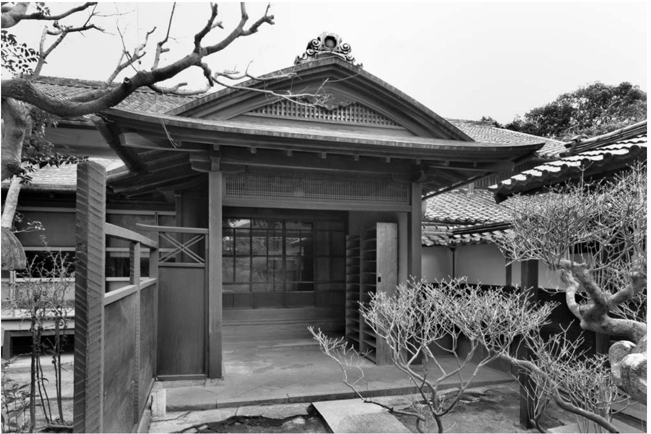
7. 主屋式台玄関（南より）
