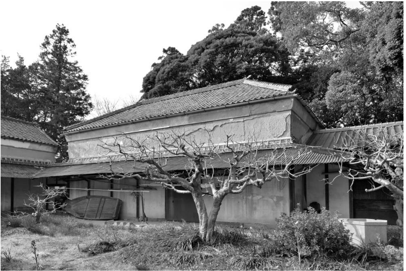
23. 北蔵全景（南東より）
