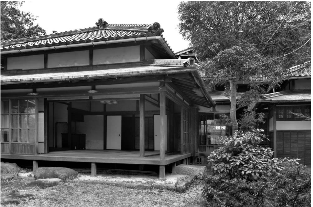
32. 奥座敷の外観（現況）
