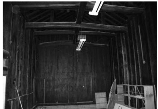
図 3-28 米蔵北側室内 (南より)
