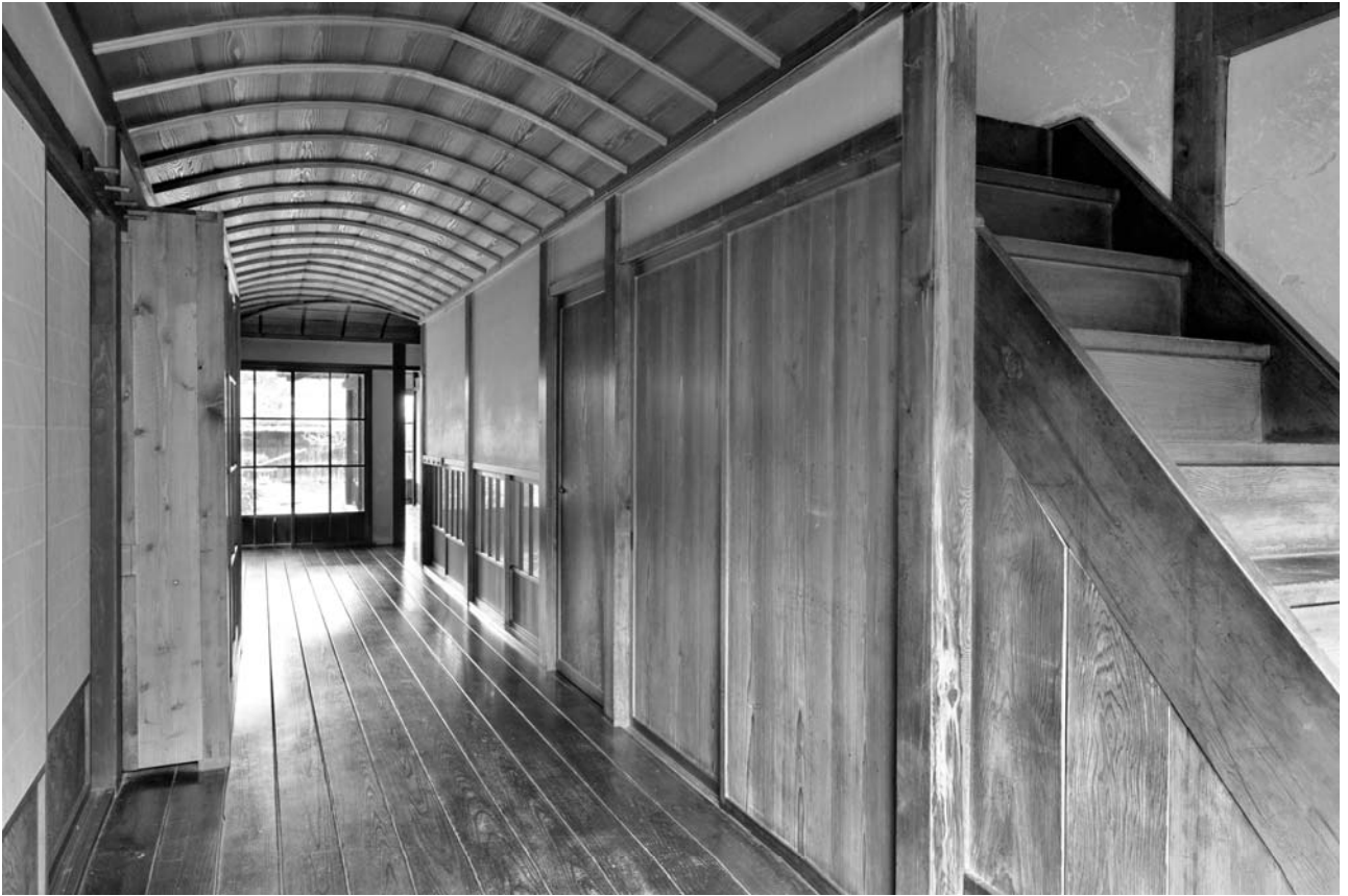
13. 二階屋一階廊下（東より）
