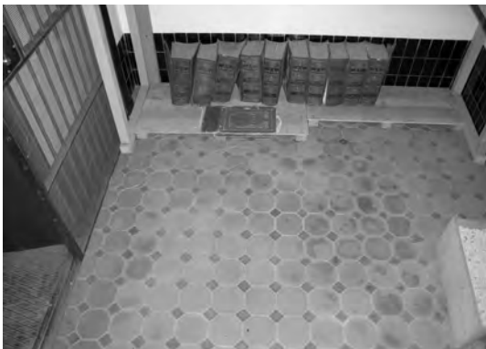
図 3-37 金庫蔵室内床タイル（南より）
