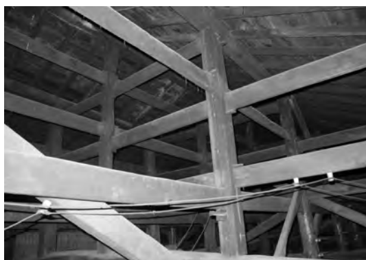
図 4-9 旧山崎家住宅西側小屋組み（床上部）
