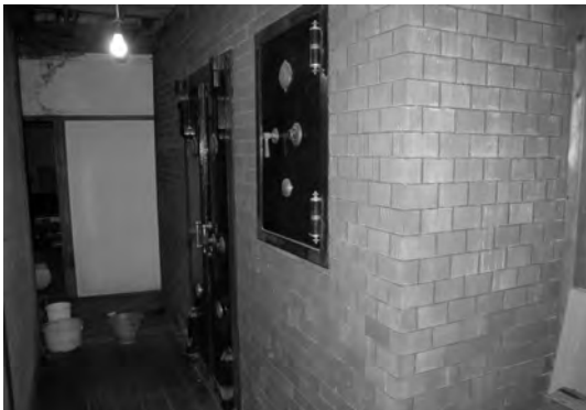
図 3-36 金庫蔵外観（南より）
