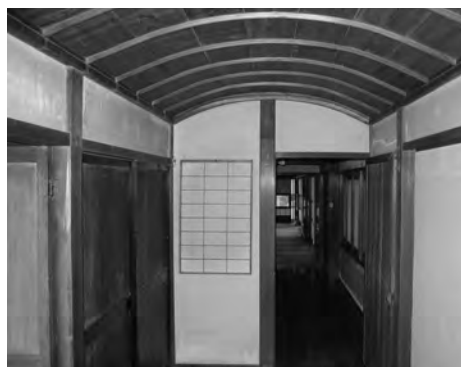
図 3-19 渡り廊下の蒲鉾天井（北より）
