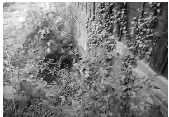
図 3-15 奥座敷棟基礎下の煉瓦積み（北西より）
