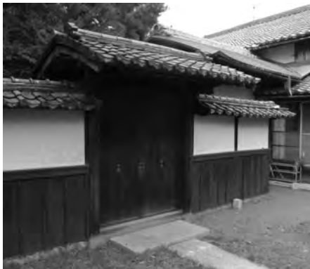
図 3-26 中門 (南東より)
