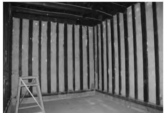
図 3-29 米蔵南側室内（北より）
