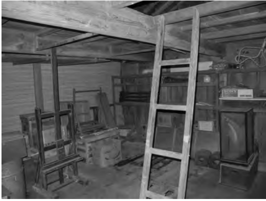
図 3-32 奥蔵室内（南西より）
