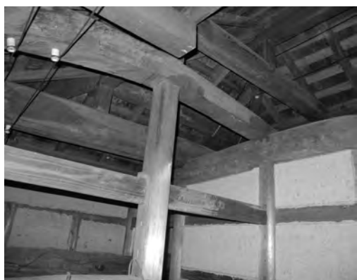
図 3-23 風呂・便所棟の小屋組み
