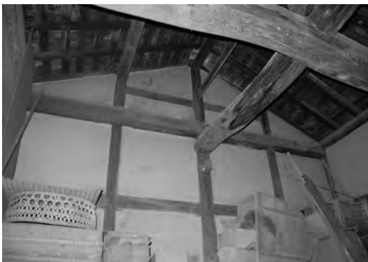
図 3-30 納屋南側室内小屋組み（南より）
