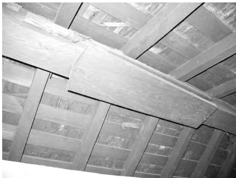
図 6-1 棟木に打ち付けられた棟札（取り外し前）
